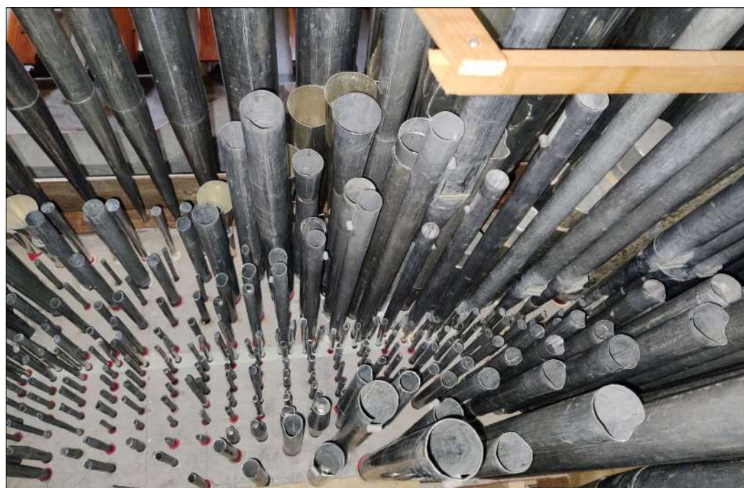
Foto 27. Veduta interna delle canne sul somiere maestro
