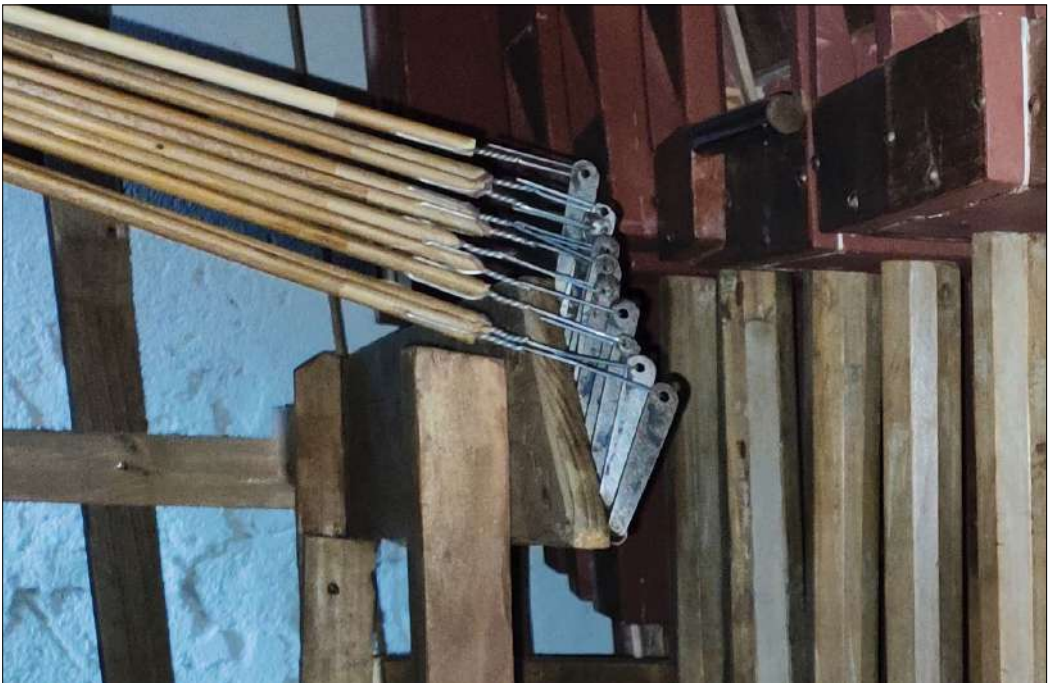
Foto 18. Dettaglio della meccanica della basseria
