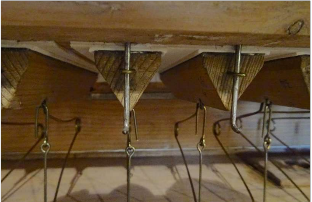
Foto 21. Dettaglio dei ventilabri e punte guida
